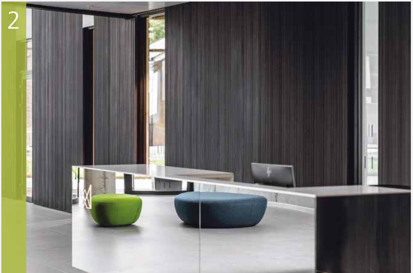
2. I PANNELLI IN UHPC, CON UNO SPESSORE DI SOLI 28 MM, SONO STATI UTILIZZATI ANCHE PER GLI INTERNI UHPC PANELS, WITH A THICKNESS OF ONLY 28 MM, WERE ALSO USED FOR INTERIORS
